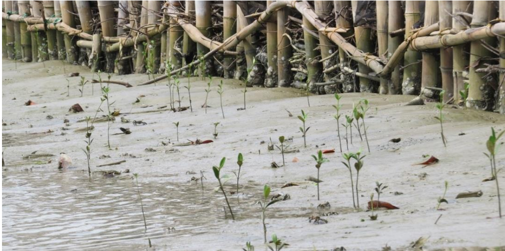
Contoh hasil teknik rehabilitasi tanpa menanam dengan membangun struktur pemerangkap sedimen, tampak anakan mangrove mulai tumbuh alami. (Foto: Apri Susanto A.)
