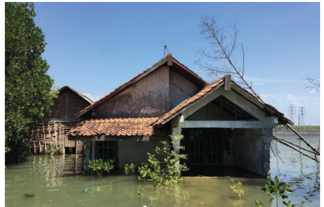
Gambar 1. Rusaknya bangunan di Semarang Utara dan tenggelamnya rumah di Sriwulan, Sayung, Demak akibat penurunan muka tanah di pantai utara Jawa Tengah
