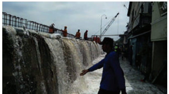
Gambar 29. Pembangunan tanggul di sepanjang pantai untuk mencegah banjir rob akibat penurunan tanah di Jakarta
