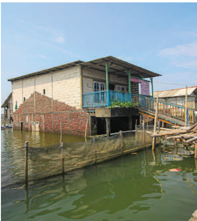
Gambar 14. Atas kiri dan kanan: Bangunan rusak di Sriwulan, Demak, Kiri bawah: Bangunan tenggelam di pantai Sriwulan. Bawah-kanan: Menaikkan bangunan untuk beradaptasi dengan penurunan muka tanah di Sriwulan, Demak.
