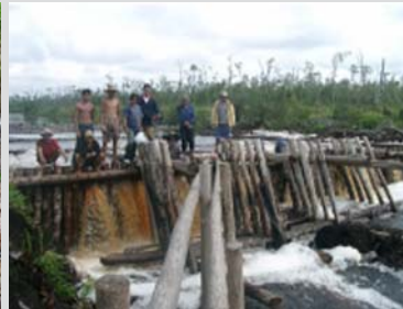
Penyekatan saluran primer utama di eks PLG-sejuta hektar, Mentangai-Kalteng
