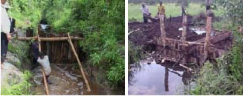
Gambar 8. Penabatan saluran di lahan gambut oleh masyarakat di Sumatera Selatan untuk mencegah kebakaran lahan di sekitarnya (Dokumentasi oleh: Ferry Hasudungan, 2004)
