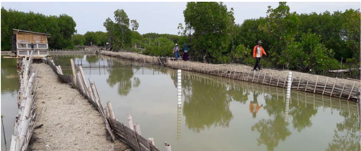
Gambar 12: Gambar tanggul baru dengan sekat-sekat bambu, yang diikat satu sama lain dengan kawat besi, masih terpasang, dan tanggul sungai yang lama sebagai latar belakang (© Roel Bosma)
