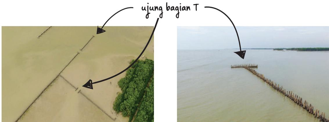
Gambar 11. Sisi potongan T dari setiap struktur yang sejajar dengan pantai dan juga di sepanjang bukaan © Pro57
