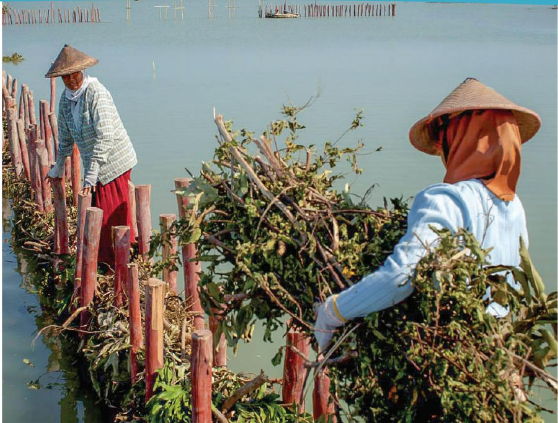
*Gambar 2. Konstruksi struktur permeabel oleh para perempuan setempat di Timbulsoko (Demak, Indonesia) © Nanang Sujana*
