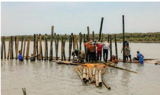
Gambar 21. Peletakan tiang vertikal dan komponen lainnya © Deinar Santayana, Witteveen+Bos
