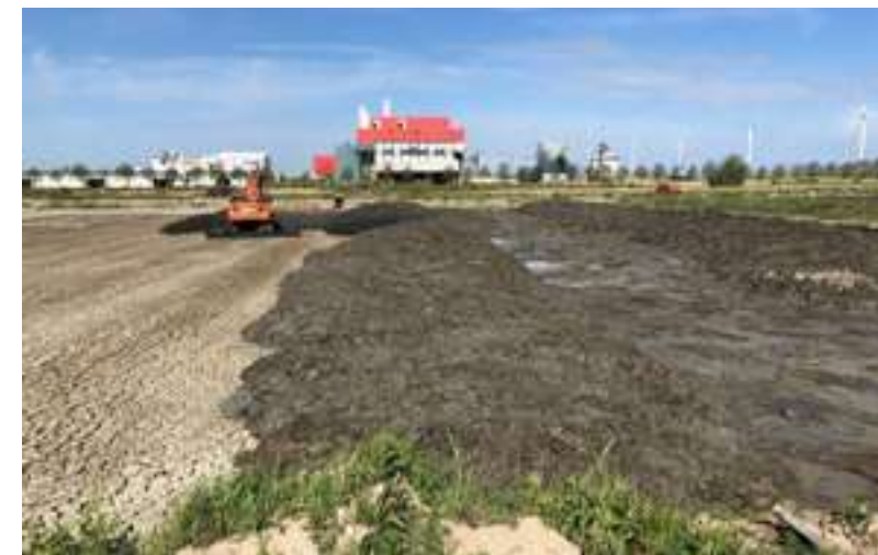
Musim Panas 2019: Tanah liat telah mengering dan sekarang dikerjakan kembali dan ditempatkan dalam alur-alur besar. Alur-alur tersebut mengoptimalkan paparan terhadap udara dan drainase, yang memfasilitasi oksidasi, menghilangkan garam dan kandungan organik.
