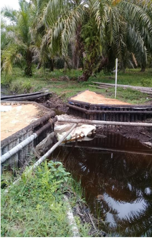
Penyekatan kanal di lahan gambut untuk mengembalikan kondisi tata kelola air gambut (Foto: Vernando Aruan)
