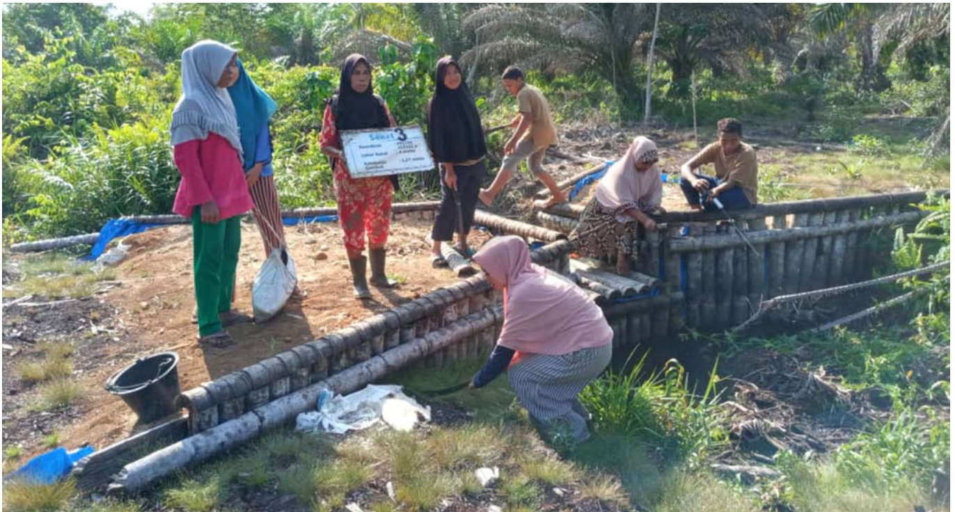
Kaum perempuan juga turut terlibat aktif dalam pembangunan sekat-sekat kanal di gambut, dalam rangka mengembalikan tata kelola air gambut yang telah terganggu akibat pembukaan kanal-kanal tersebut. (Foto: Didik Fitrianto)
