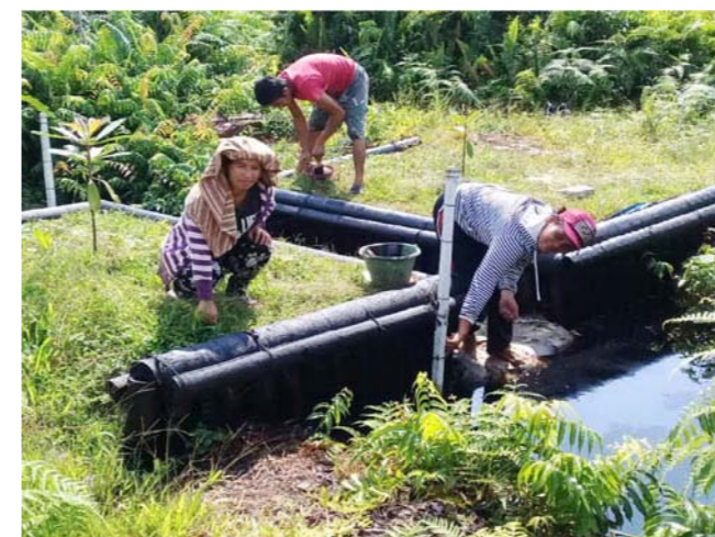
Restorasi gambut dengan penyekatan kanal dan penanaman tanaman asli gambut
