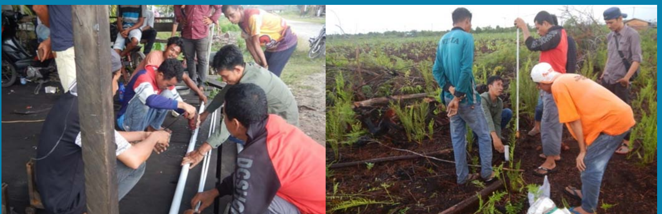
Mempersiapkan dan merakit bahan-bahan alat ukur sumur pantau (kiri); Pemasangan alat ukur sumur pantau di lokasi (kanan). (Foto: Dok. WALHI, Riau)
