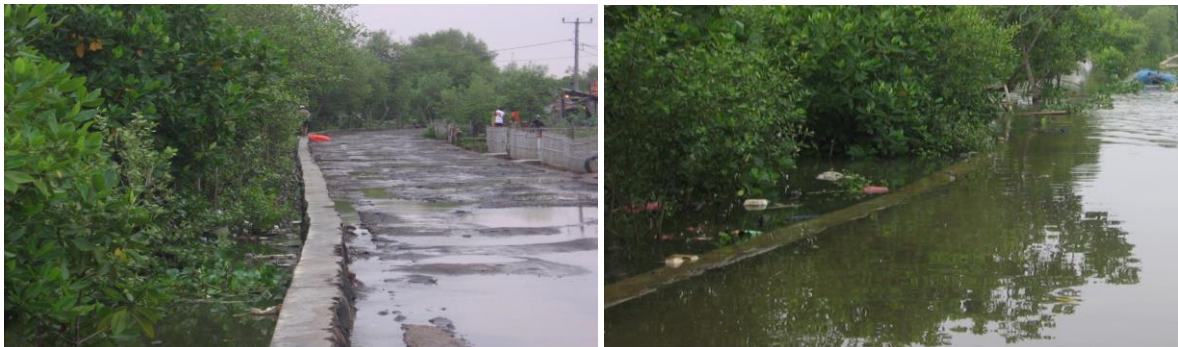
Gambar 13. Pembuatan tanggul di pinggir pantai dan penanaman bakau untuk mencegah banjir pasang laut “rob” akibat subsiden tanah di PANTURA. Setelah tanggul dibangun dan bakau ditanam, “rob” tetap datang
