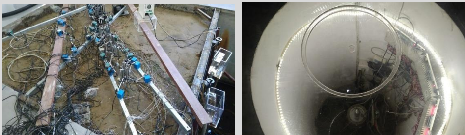
Gambar 17. Perangkat pemantauan Subsiden tanah di kota Shanghai.
