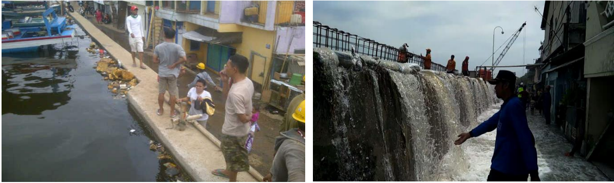
Gambar 10. Pembuatan tanggul di pinggir pantai untuk mencegah banjir pasang laut “rob” akibat subsiden tanah di Kota Jakarta. Setelah kurang dari sepuluh tahun “rob” kembali datang, air laut seolah naik kembali hingga mencapai lebih dari satu meter.
