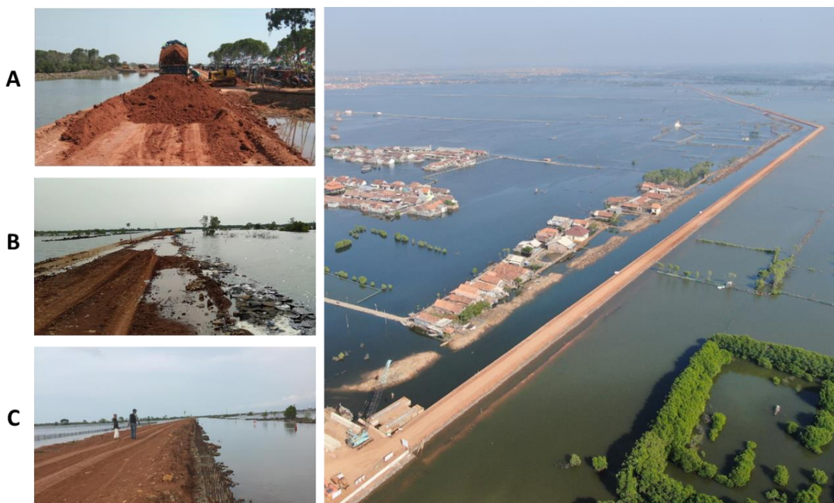
Gambar 11. Pembuatan tanggul di pinggir pantai untuk mencegah banjir pasang laut “rob” yang diakibatkan oleh subsiden tanah di Kota Pekalongan. Kondisi beberapa saat setelah proses pengurangan tanah tanggul (A), Kejadian “rob” datang kembali (B), Tanggul harus ditinggikan lagi akibat “rob” datang kembali (C). Foto courtesy Hakam dan BBWS.
