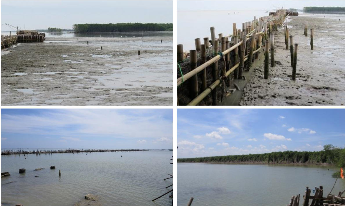
Gambar 12. Upaya menangkap sedimen untuk mencegah datangnya “rob” di daerah Demak. Sedimen bertahan tidak lama karena kembali terbarasi. Foto courtesy Yayasan lahan Basah ( Wetland International Indonesia)
