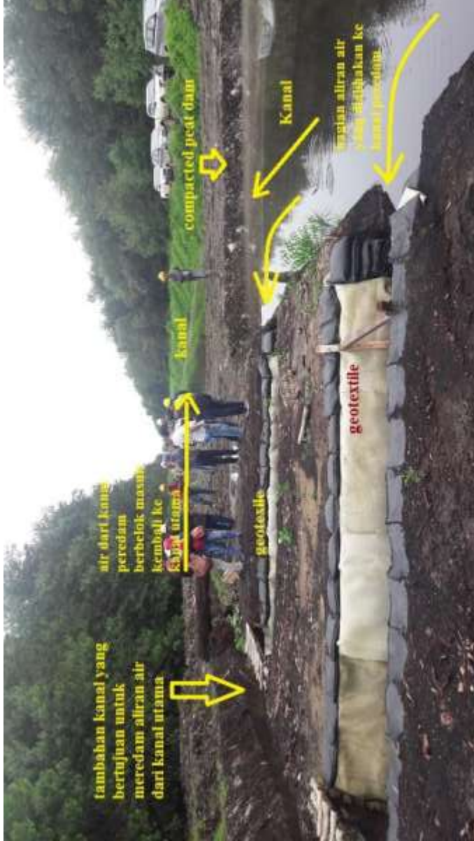
Gambar 68. Salah satu sekat kanal ( compacted peat dam ) yang dibangun di dalam konsesi HTI APP, di Sungai Buluh, Provinsi Jambi (Februari 2017; Foto oleh Nyoman Suryadiputra).
