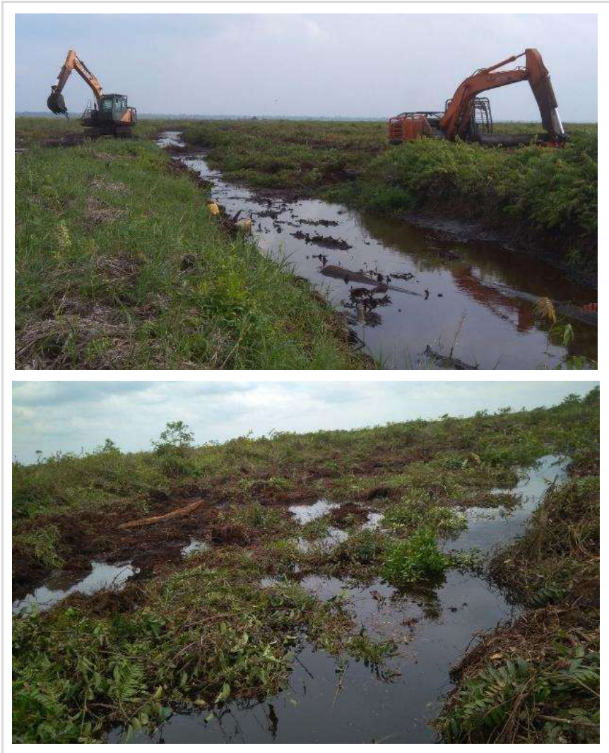
Gambar 79. Bagian kanal yang diurug ( partially canal infilling ) di Tahura OKH, Jambi. (Foto oleh: Jarwo Susanto, 26 Februari 2018).
