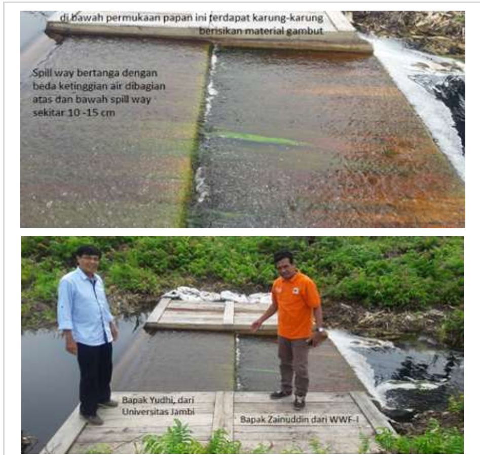
Gambar 33. Sekat kanal yang dibangun dibagian sisi timur dari HLG Londerang dengan papan tutup (ukuran lebar kanal sekitar 6-8 meter), (Foto oleh Nyoman Suryadiputra, Desember 2017).
