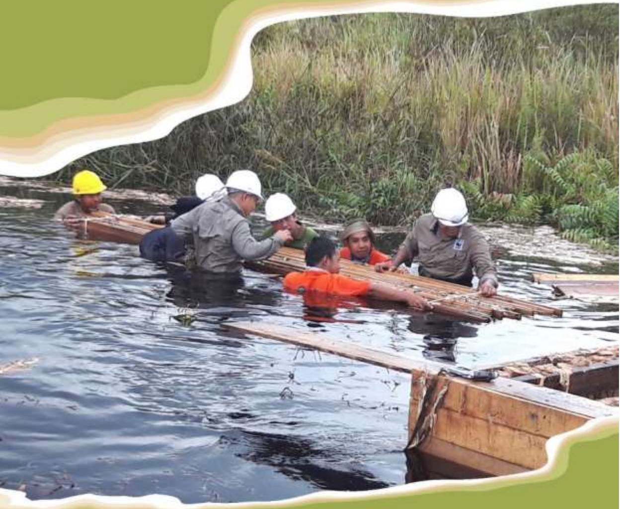
Kayu gelam yang dikumpulkan untuk penyekatan kanal di bagian barat laut HLG Londerang (Desa Teluk Dawan) (Foto: I Nyoman Suryadiputra)
