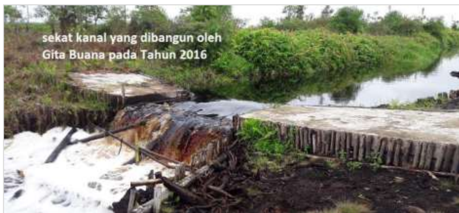
Gambar 70. Sekat kanal di Tahura OKH yang dibangun oleh Yayasan Gita Buana pada tahun 2016, beberapa bulan setelah kebakaran pada tahun 2015 (Foto Nyoman Suryadiputra, Desember 2017).
