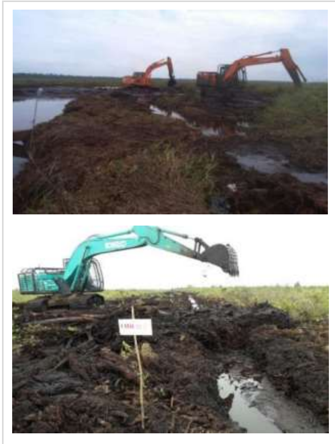
Gambar 76. Pembangunan sekat kanal dengan bahan gambut yang dipadatkan. Foto kiri: menggunakan 2 ekskavator untuk kanal yang lebarnya > 4 meter. Foto kanan: menggunakan 1 ekskavator untuk kanal yang lebarnya < 4 meter). Foto: Jarwo Susanto, Feb 2018.
