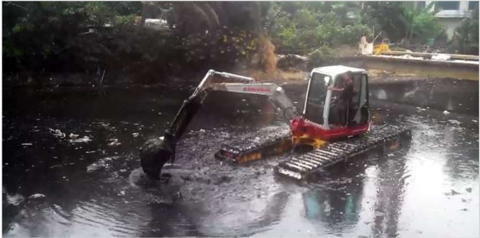
Gambar 72. Excavator Amfibi yang dapat dioperasikan di atas air dan lahan gambut
