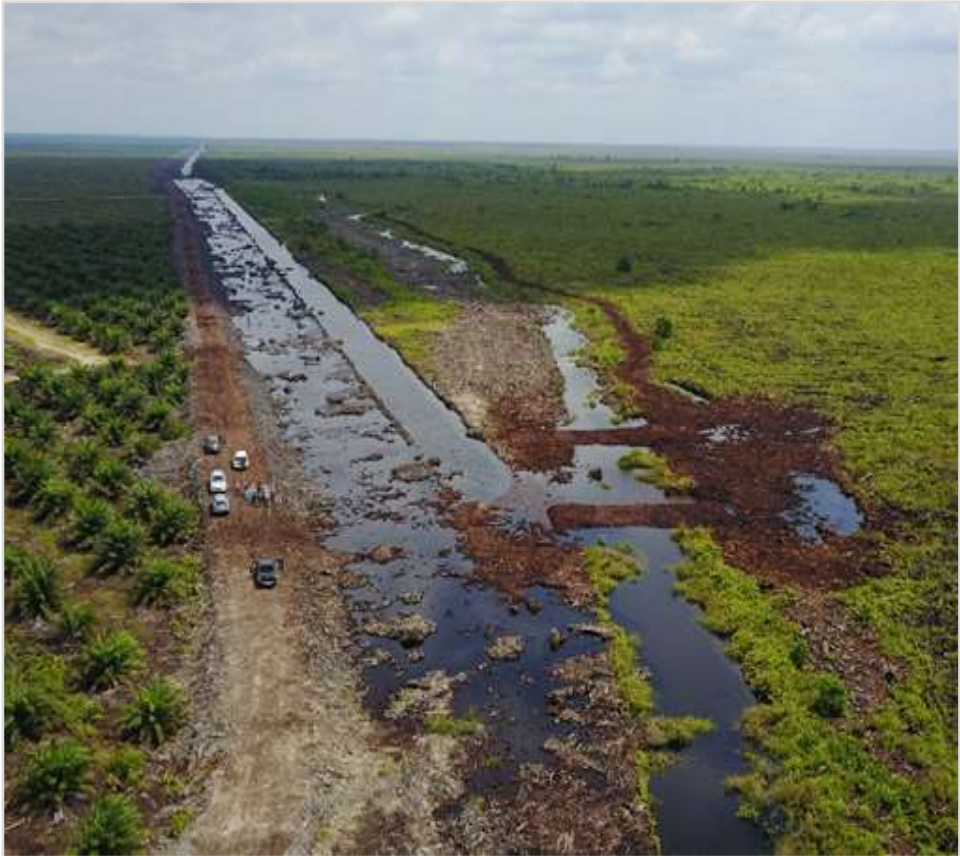
Gambar 74. Pembangunan sekat compact peat dam dengan lubang bekas galian gambut di dekatnya (Foto Drone oleh I. Reza Lubis, 1 Feb 2018).
