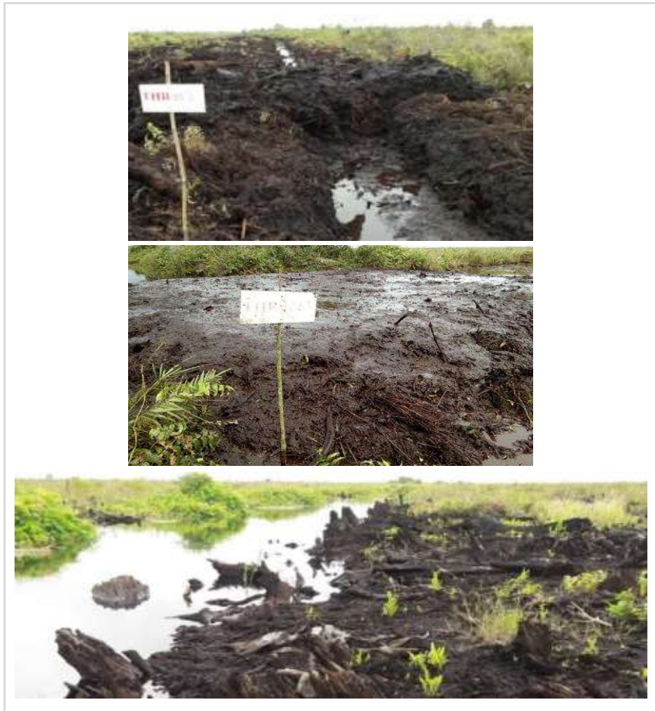
Gambar 80. Bahan gambut yang digunakan dalam konstruksi sekat kanal di Tahura OKH, masih banyak mengandung akar tanaman dan sisa-sisa batang/onggok kayu tanaman bekas kebakaran tahun 2015 (Foto atas: Jarwo Susanto, Feb 2018. Foto bawah: Nyoman Suryadiputra, Desember 2017).
