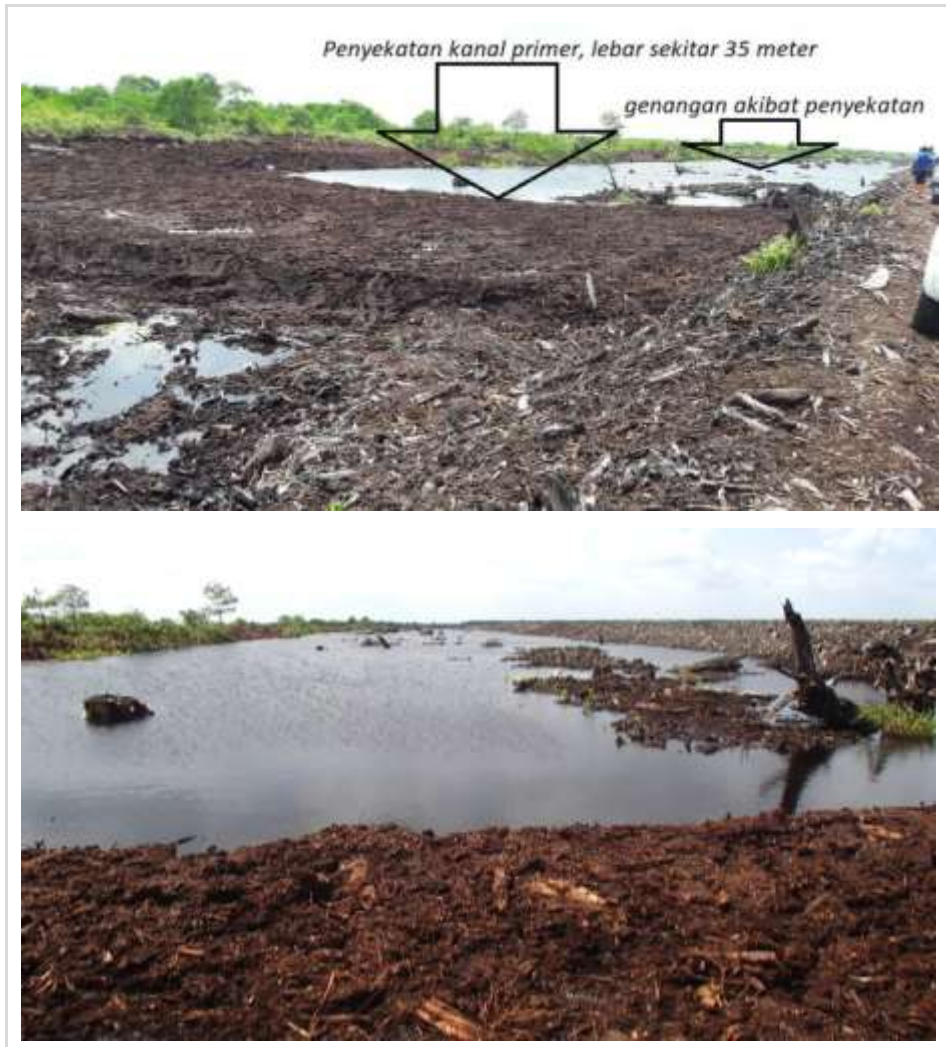
Gambar 77. Kanal primer (35 meter) disekat menggunakan bahan gambut yang dipadatkan ( compacted peat dam ) menimbulkan genangan air dibagian atas sekat (Foto atas oleh Nyoman Suryadiputra dan bawah oleh I Reza Lubis, Feb. 2018).
