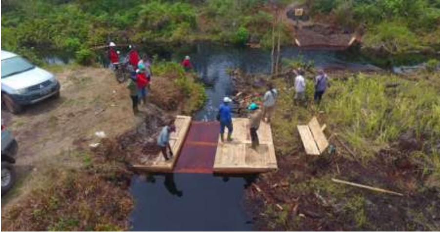
Gambar 35. Kanal yang berukuran kurang dari 4 meter, bentuk sekat kanal agak sederhana (Foto oleh WWF-I, 2017).
