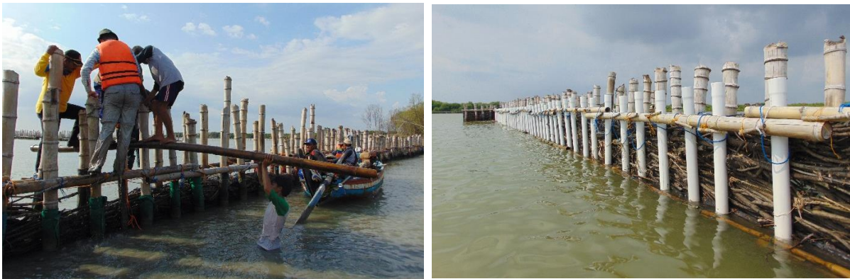
Gambar 17. Pembangunan struktur permeabel oleh masyarakat (kiri); Struktur permeabel yang sudah dibangun (kanan). (Foto Eko Budi Priyanto)
