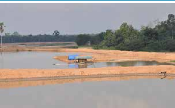
Gambar 2. Kolam pengendapan sebelum air dialirkan ke sungai (Foto: M. Arief S.)
