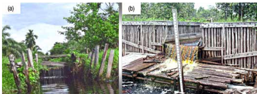
Gambar 1. Penutupan saluran air (parit dan kanal). (a) Kesatuan Pengelolaan Hutan Lindung Gambut (KPHLG) Bram Itam, Jambi, menggunakan sistem buka tutup secara manual; (b) Taman Nasional Sebangau, Kalimantan Tengah
