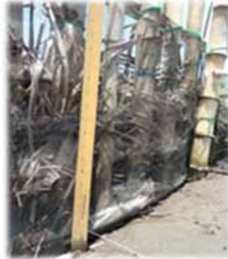
Pemasangan alat pengukur sedimen
