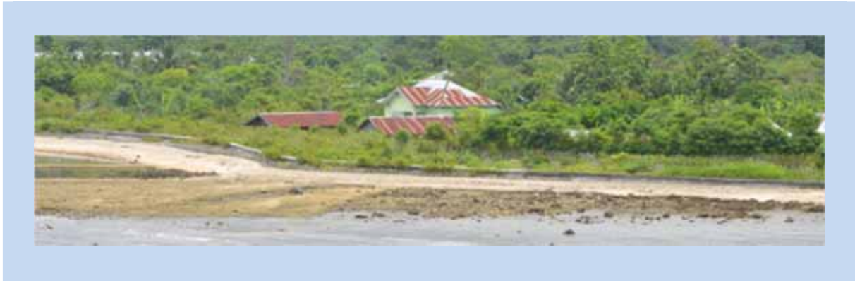
Gambar 29. Tanggul yang dibangun di sepanjang pantai untuk mengantisipasi abrasi
