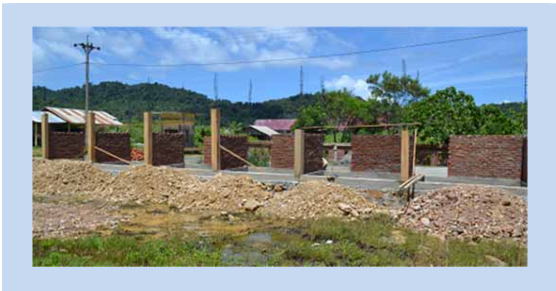
Gambar 36. Pembangunan kios ikan yang sedang berjalan
