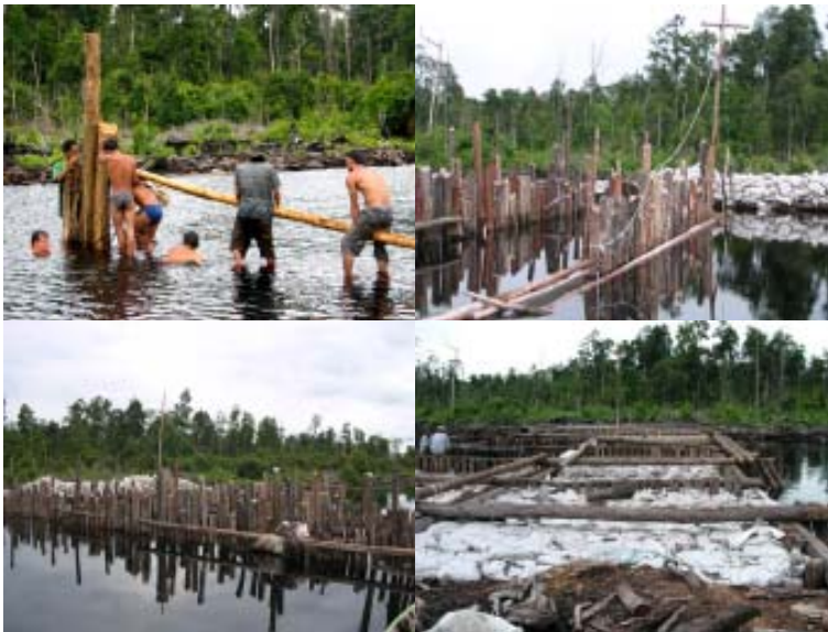
Gambar 12. kegiatan penyekatan saluran ex-PLG (Foto : Alue Dohong)
