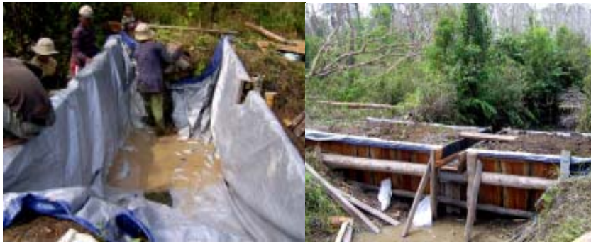
Gambar 15. Sekat permanen di Parit hutan rawa gambut Merang – Kepayang (Foto: WBH)
