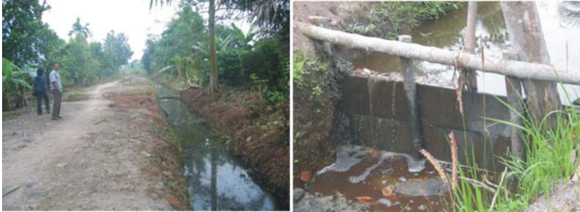
Gambar 35. Permukaan air di parit sudah naik (kiri), sebagai hasil pengelolaan pintu air (kanan). (Dokumentasi oleh: Indra Arinal, 2004)
