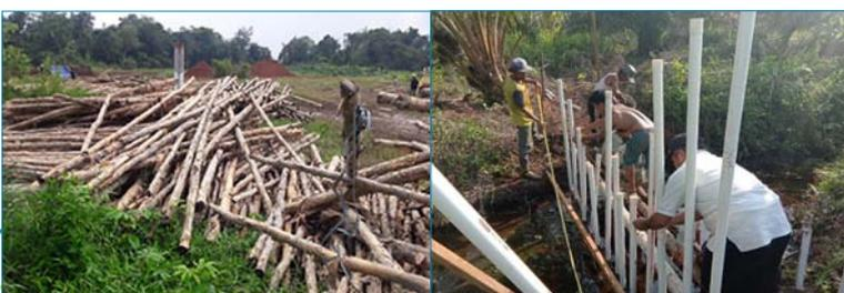
Kayu gelam banyak dibutuhkan untuk membangun *composite box dam* (kiri), alternatif lain dapat menggunakan pipa PVC yang berisikan coran beton (kanan). (Foto: Dok. YLBA/WII, 2018 dan 2019)
