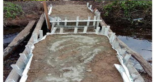
Mengangkut kayu menggunakan aliran air di dalam kanal (atas), dan bentuk tampilan *composite box dam* berbahan pipa PVC dengan adonan beton di dalam pipa (bawah). (Foto: Nyoman Suryadiputra, 2017)
