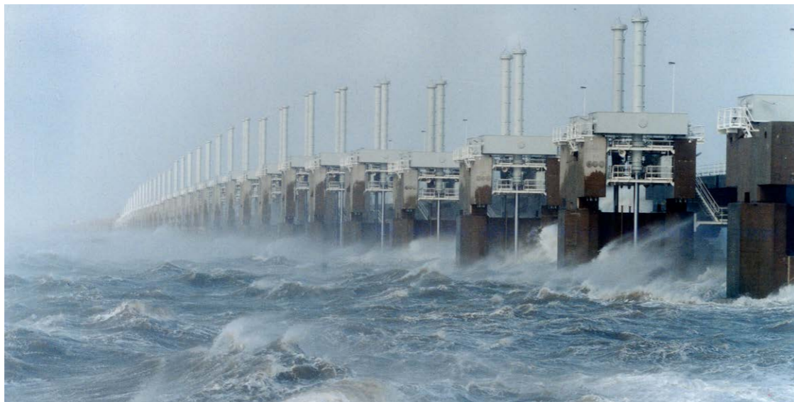
Figure 2: Eastern Scheldt barrier @ https://beeldbank.rws.nl , Rijkswaterstaat
