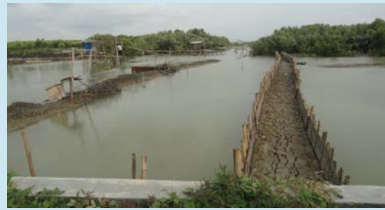
2. Tiang bambu yang sudah terpasang kemudian bagian dalamnya diberikan bambu yang telah dianyam terlebih. Setelah semua siap baru ditambahkan lumpur, lumpur diperoleh dari tambak bagian dalam, sehingga tanggul baru mulai terbentuk (1 Februari 2018).
