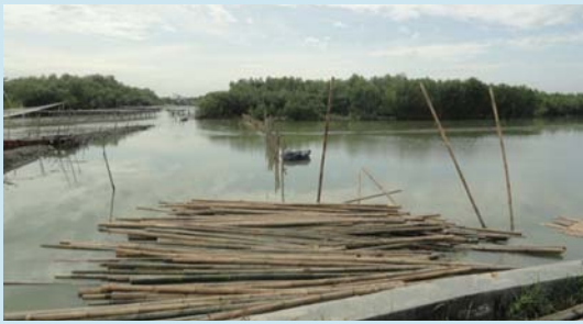
1. Material bambu pancang untuk pembuatan tanggul baru, rencana jarak tanggul baru dengan tanggul lama 10 meter. (Desember 2017)
