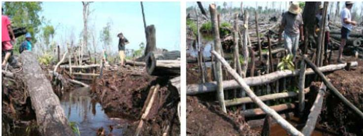
**Gambar 51. Kegiatan konstruksi sekat**
