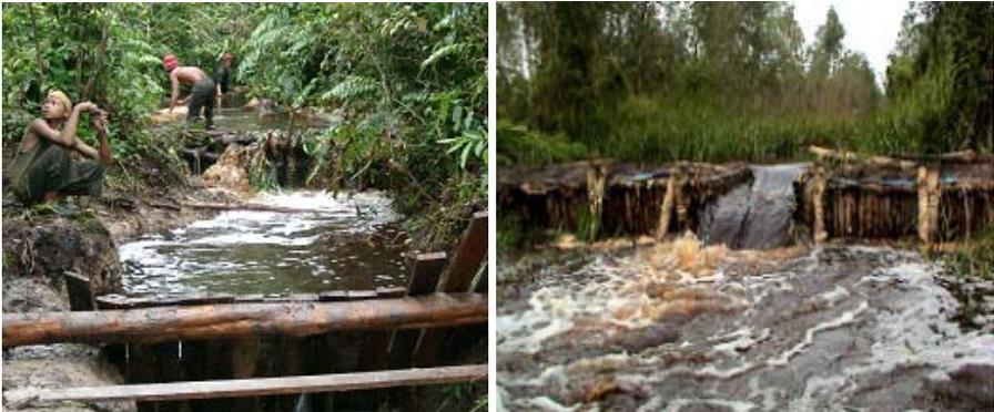
***Gambar 75. Sistem buka - pasang tabat/sekat sementara di parit-parit sekitar Sungai Merang. (Kiri: parit dengan kondisi tabat terpasang dan kayu mengapung. Kanan: tabat dibuka, lalu kayu dilewatkan. (Foto. Suryadiputra, Juni 2004)***
