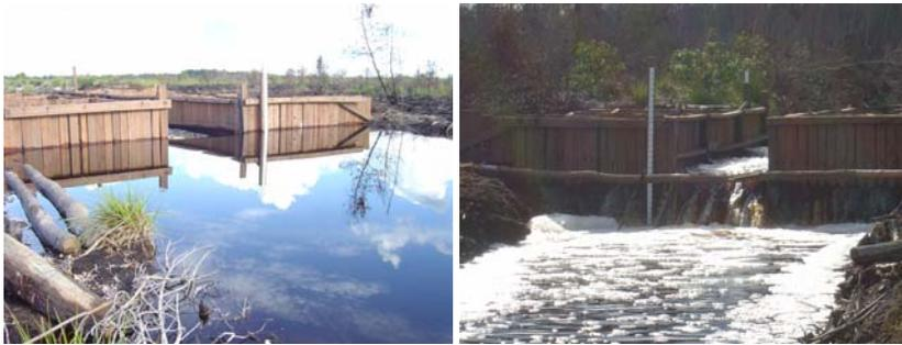
**Gambar 72. Konstruksi Tabat di Saluran ex PT SSI Setelah Selesai Dibangun (Dokumentasi: WWF-Indonesia/Drasospolino, 2004)**
