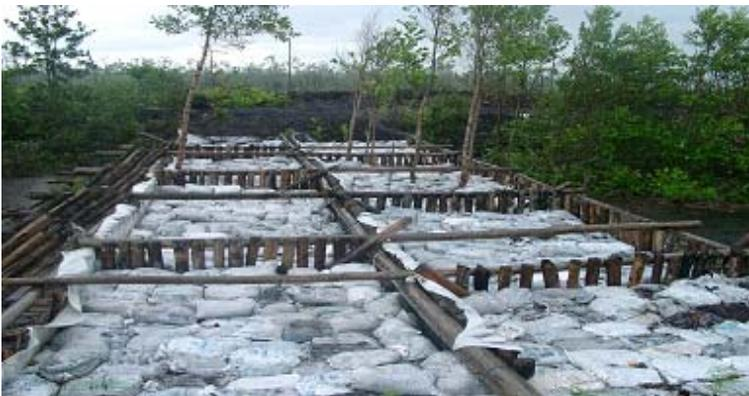
**Gambar 34. Kondisi tabat SPP-SPU 7 yang sudah berisikan karung-karung tanah (Foto: I N.N. Suryadiputra 2004).**
