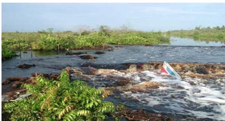
**Gambar 46. Debit air yang besar pada tabat 2 di SPI-1 menggerus lahan gambut di sisi tabat (Foto: I N.N. Suryadiputra, Maret 2005).**
