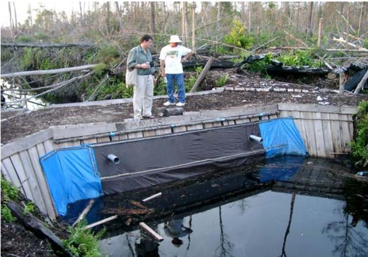
**Gambar 11. Sekat isi yang dibangun oleh Yayasan MAWAS - BOS di salah satu saluran eks-PLG, Kalimantan Tengah**
