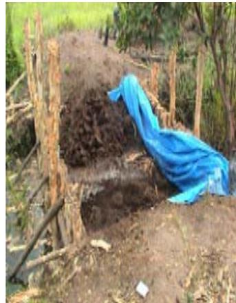
**Gambar 80. Pemasangan cerucup di dalam saluran yang ditabat**
