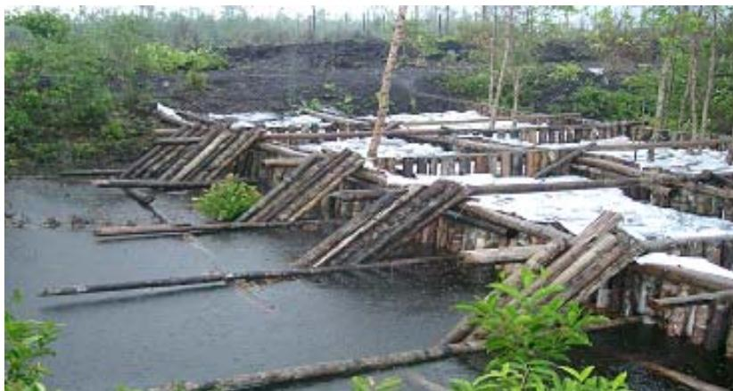
**Gambar 33. Model tabat DTM-2 dengan kamar-kamar di dalamnya dan tiang penopang pada bagian hilirnya. Tabat telah dilapisi geotextile dan kamar-kamarnya telah diisi karung-karung dengan tanah mineral di dalamnya (Foto: I N.N. Suryadiputra 2004).**
