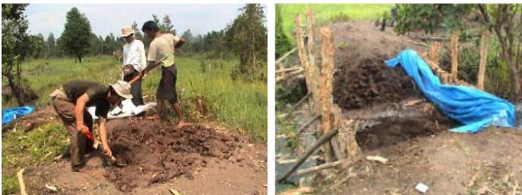
**Gambar 84. Penimbunan tanah di dalam tabat**
