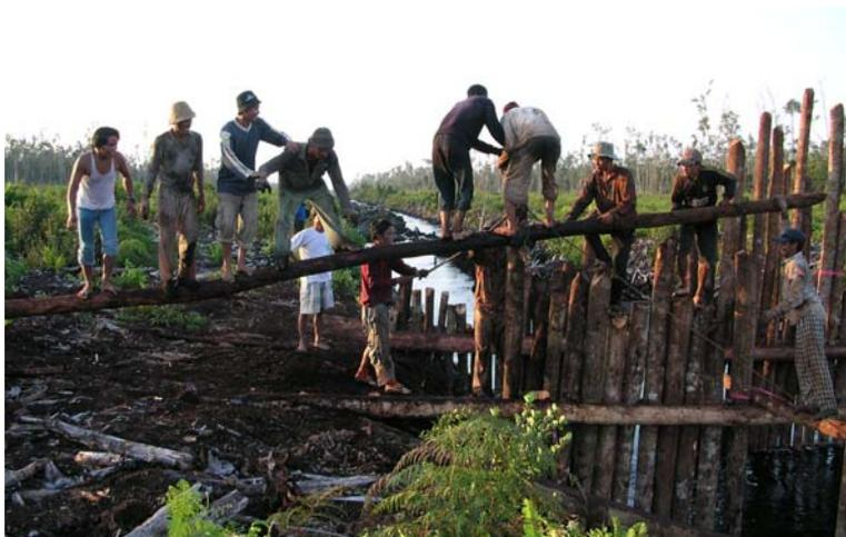
**Gambar 31. Para pekerja sedang menginjak-injak balok horizontal agar tiang blangeran tertancap melesak jauh ke dalam tanah gambut (Foto: I N.N. Suryadiputra 2004).**
