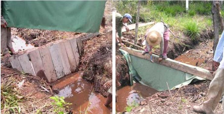
**Gambar 50. Pemasangan plastik atau terpal pada dinding sekat**
