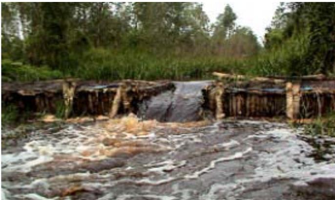
**Gambar 73. Konstruksi Tabat di Saluran Sami Setelah Selesai Dibangun (Dokumentasi: WWF-Indonesia/Eko Manjela, 2004)**
