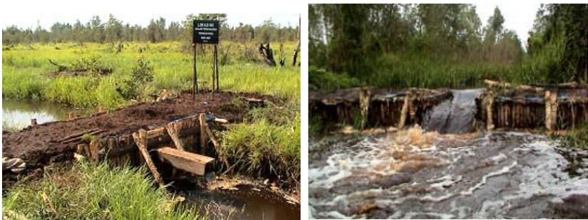
**Gambar 85. Posisi dan bentuk saluran pembuangan air (spillway) di tengah tabat**
