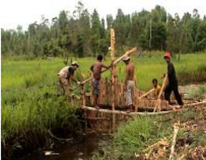
**Gambar 81. Pemasangan penyangga tegak**
